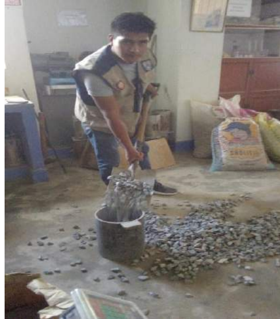
Fotografía N° 20: llenado del agregado grueso
