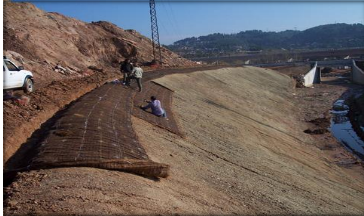
Figura 38: Geomalla Colocación
