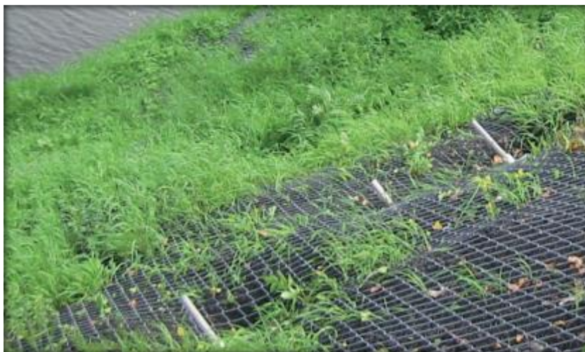
Figura 40: Final de la Colocación Geomalla.
