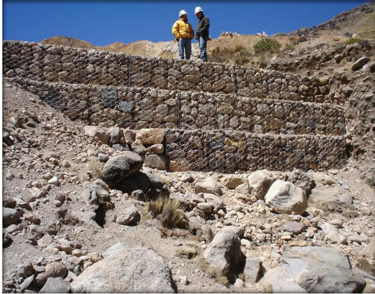
Figura 01: Estabilización de Talud con Gaviones Fuente: Método de Análisis de Estabilidad de Taludes
