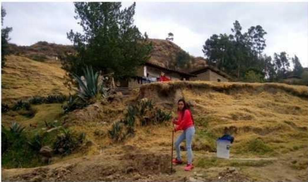
Foto N°02: Localización en el terreno y excavación de la calicata.
