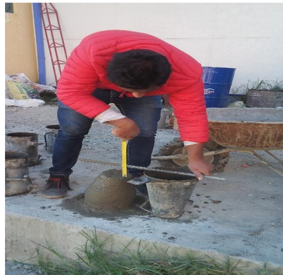
Foto N°27: Medición del Slump.
