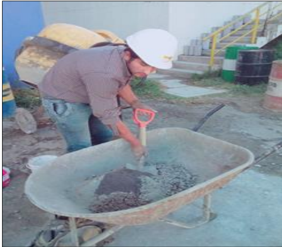
Foto N°34: Mezclado en buggy los materiales con ceniza de hoja de pino
