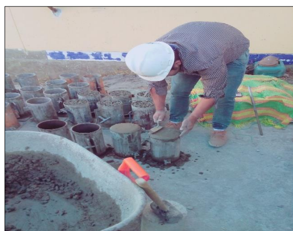
Foto N°37: Se enraso la parte superior con la plancha.
