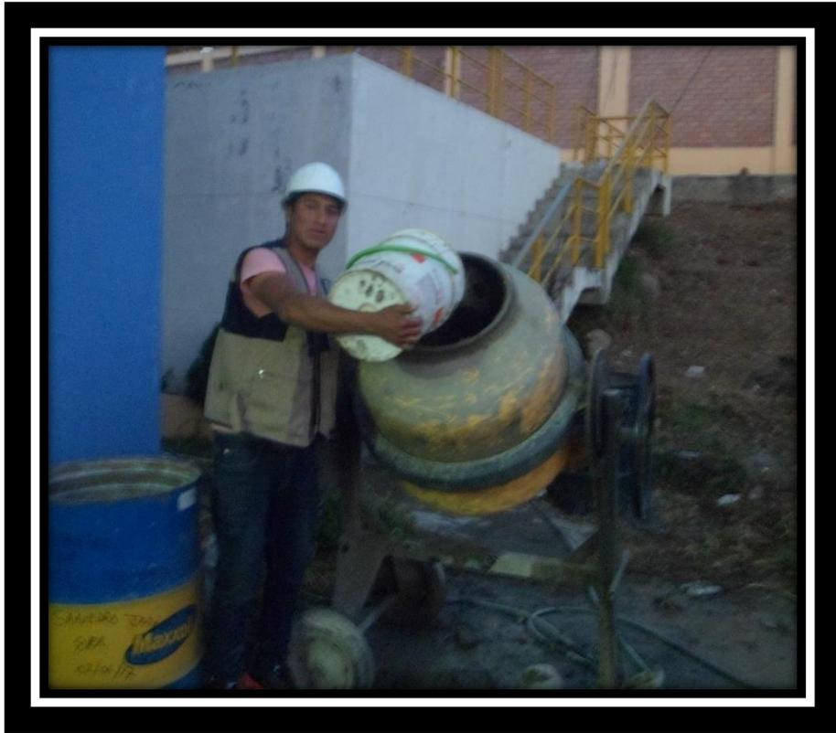
**Foto 13: Agregando el cemento a la mezcla del concreto.**
