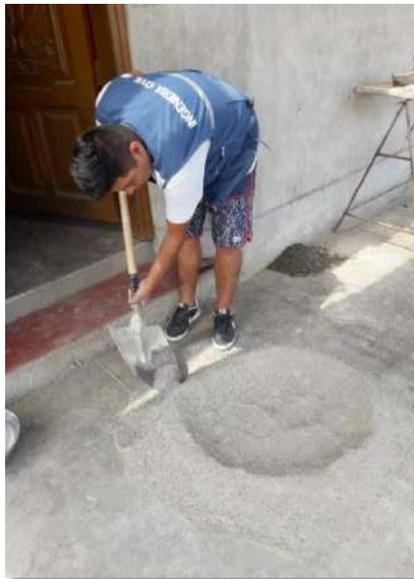
**Figura 43.** La elaboración del ladrillo patrón fue manualmente, se hizo 6 vueltas la mezclas
