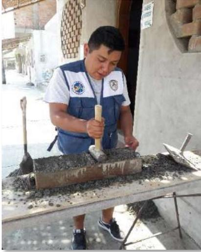
**Figura 45.** Se procede a echar la mezcla a los moldes 24x14x9 cm, y un compactado y enrasado
