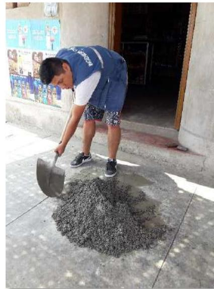
**Figura 44.** Se hecho el agua para seguir mezclando, como máximo 6 vuelta.
