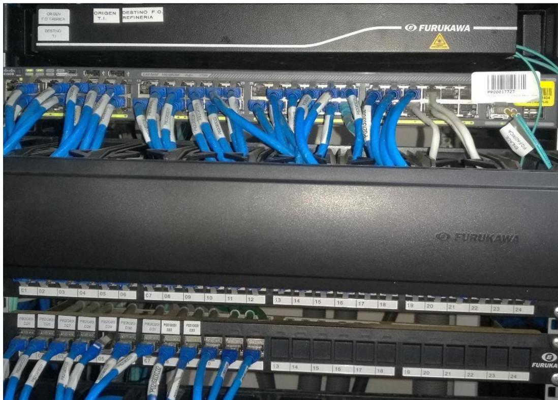
Figura 43: Switch del área de Fábrica
