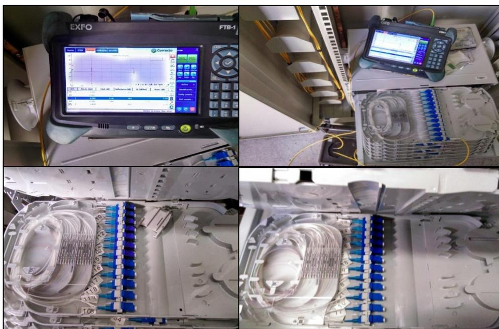
Figura N° 33 Medición y colocación de fibra óptica a las bandejas.
