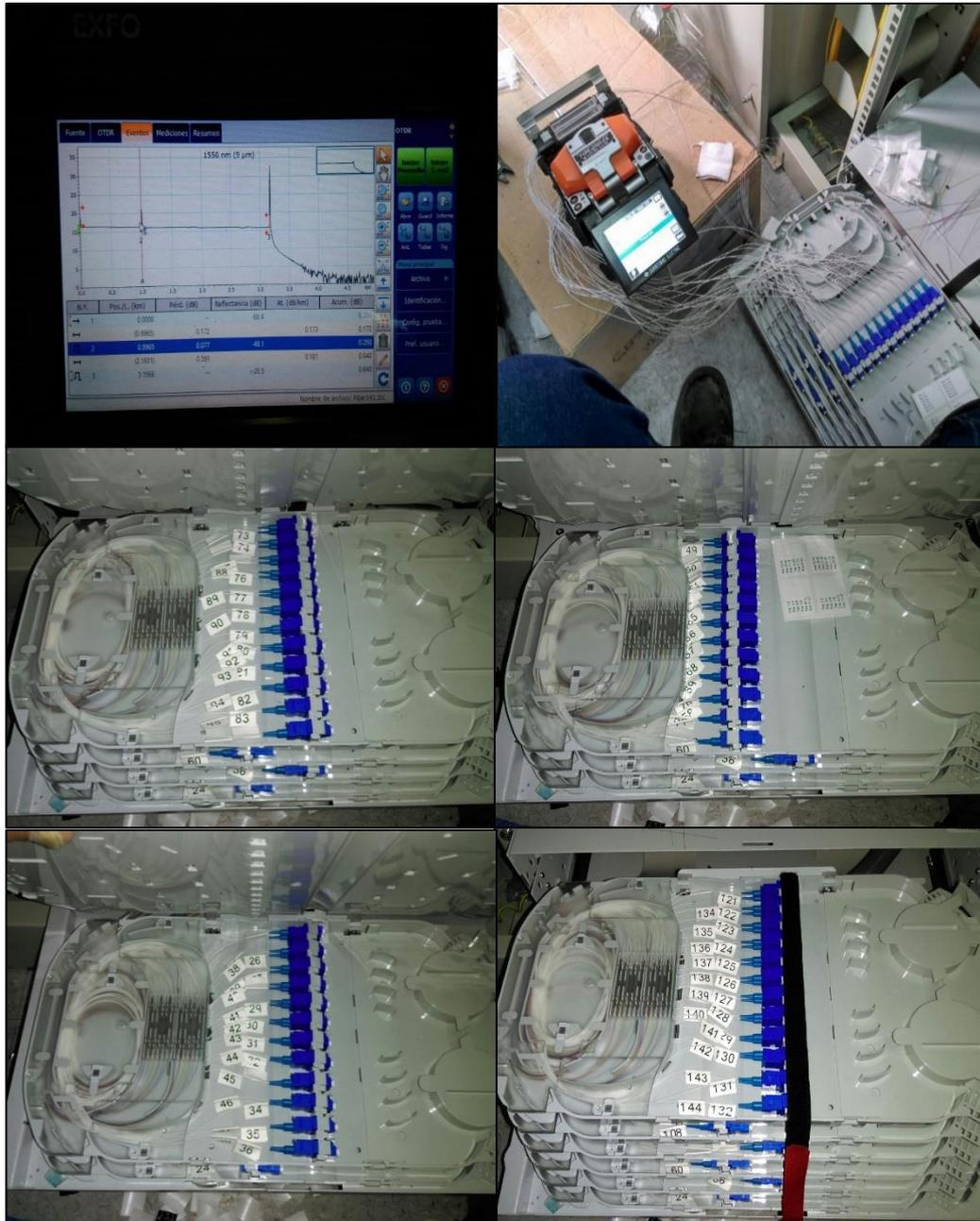
Figura N° 31 Medición y colocación de fibra óptica a las bandejas.
