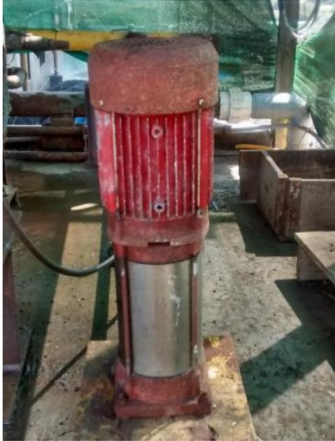
**Figura 16.-** Fotografía Electrobomba de limpieza del tromel.
