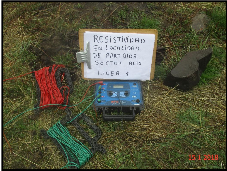
FIGURA N° 13. Preparación de telurometro para iniciar prueba de resistividad en la localidad Parañida Sector Alto 1
