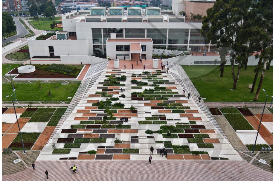
Figura 24: Vista del Parque Biblioteca-Centro Cultural Julio Mario Santo Domingo Fuente: Archivo de Archdaidly-Arquitectura-Paisaje-Espacios Verdes
