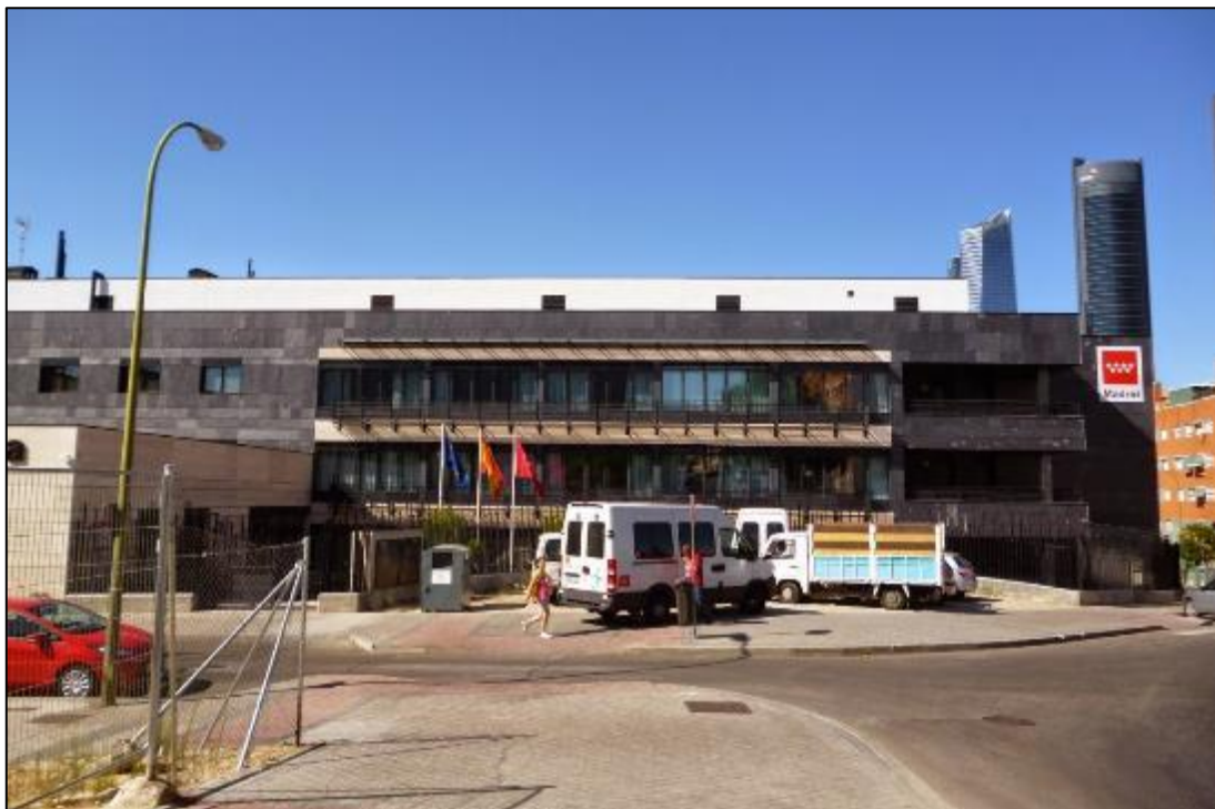
Figura 30. Fachada principal de la residencia y centro de día Isabel la Católica.
