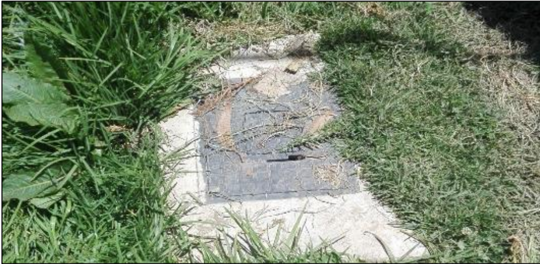
Figura 7. Servicio de agua potable.
