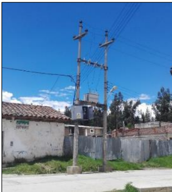
Figura 9. Transformador eléctrico.
