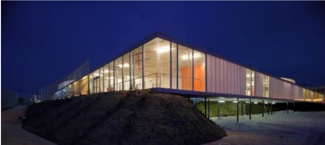
Figura 27. Fotografía de sistema estructural.
