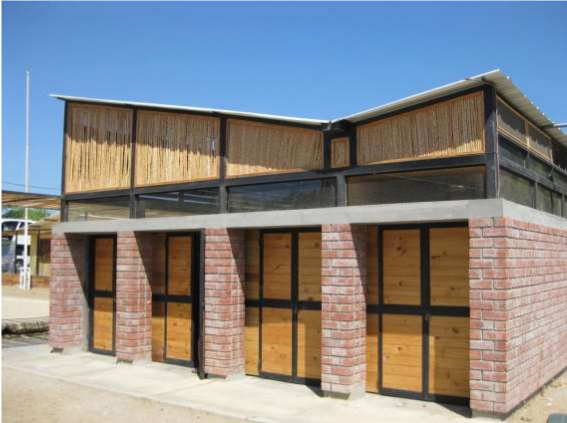
Figura 19 Fotografía Exterior del Aula, mostrando el techo alto.
