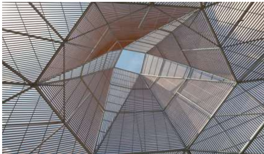
Figura 5 Cobertura de Acero y madera del Colegio Pies Descalzos
