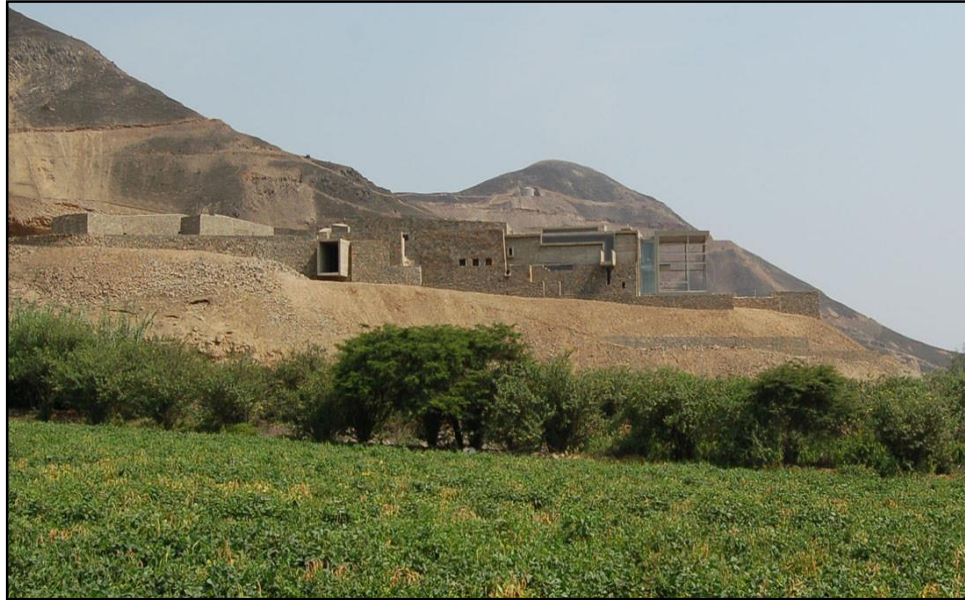
IMAGEN FACHADA PRINCIPAL
