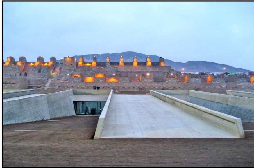
IMAGEN DE FACHADA PRINCIPAL DEL PROYECTO
