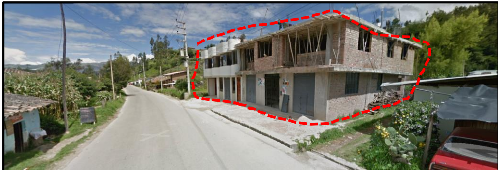
Figure 7: Viviendas de concreto -Ventanillas de Otuzco Fuente: Fotografía Propia
