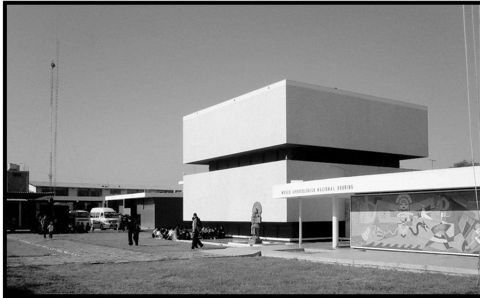
IMAGEN FACHADA PRINCIPAL
