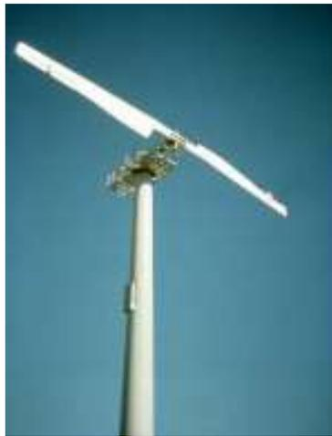
Figura N°07. Aerogenerador por número de Palas - De Dos Palas
