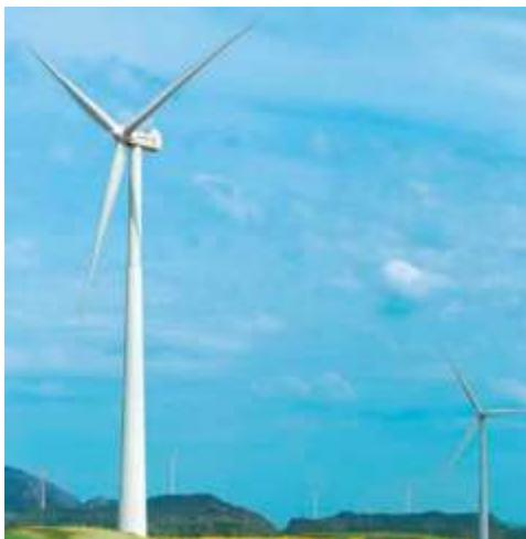
Figura N°05. Aerogenerador de Eje Horizontal
