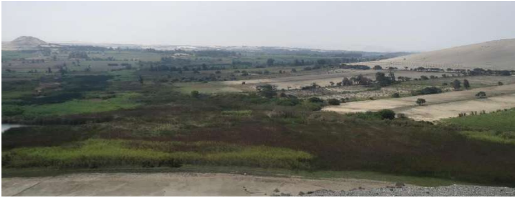
Figura: 73 Vista 360° hacia el Cerro Tangay – giro izquierdo. Fuente: Propia
