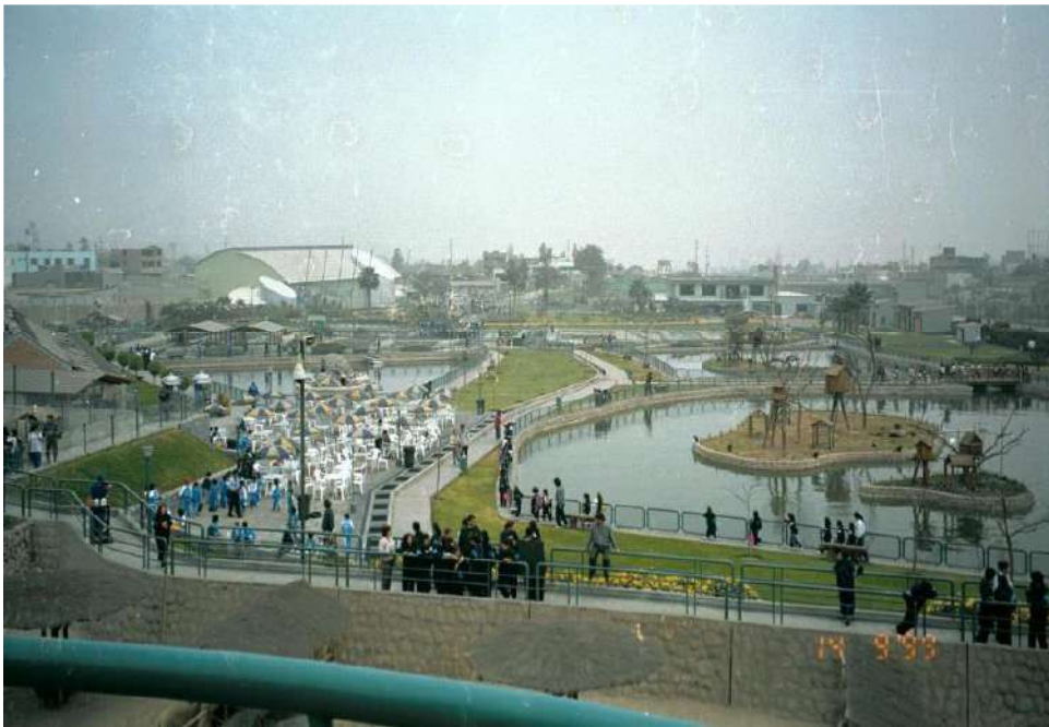
Figura: 28 Vista general de las instalaciones.
