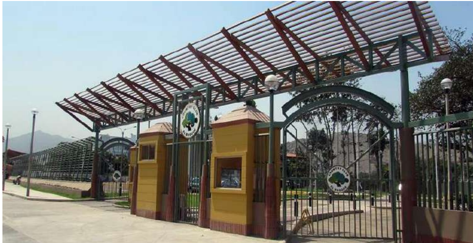
Figura: 38 Ingreso al Centro Recreacional
