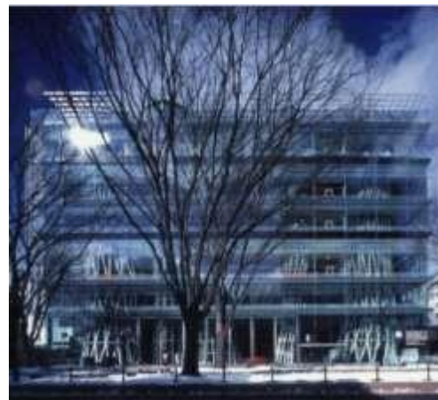
Figura 35. características del contexto/ Fuente www.archdaily.pe y elaboración propia.
